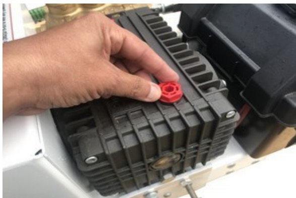
Figura # 5 - Puerto de llenado de aceite en la bomba
